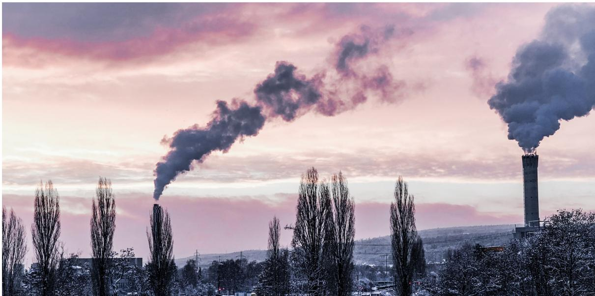
**La chaleur récupérée dans l'usine d'incinération d'ordures ménagères de Hagenholz (à droite) couvre toute l'année une grande partie des besoins d'énergie du réseau de chauffage urbain de Zurich. D'octobre à mai, la centrale de chauffage au bois d'Aubrugg (à gauche) est utilisée en renfort.** *Source : Melanie Haupt, ETH Zürich.*
