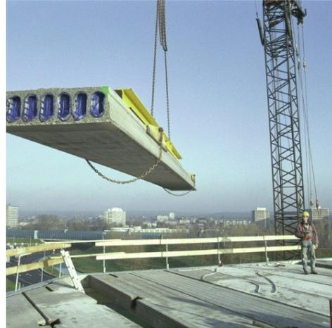
Béton avec fibres de carbone précontraintes
