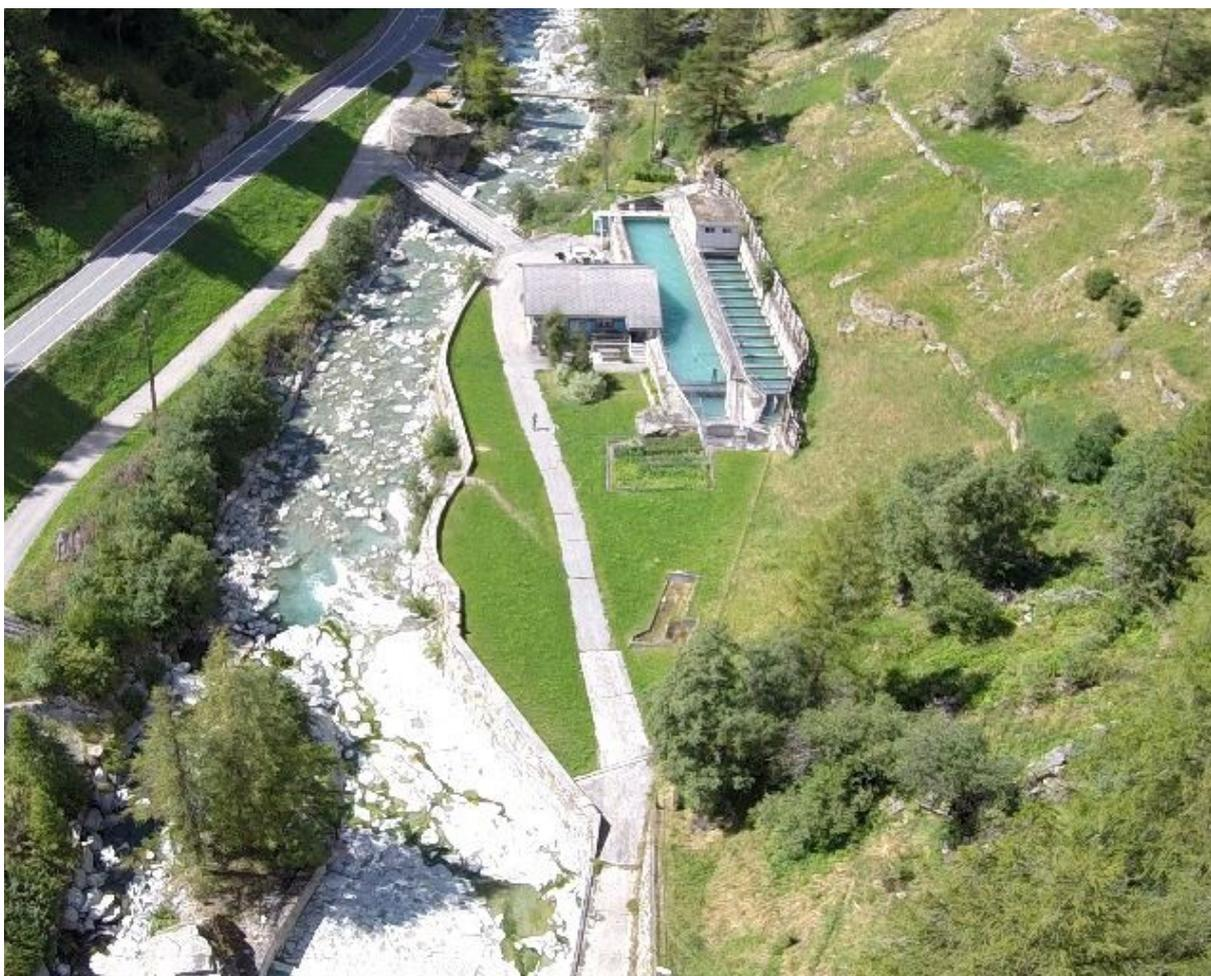
L'eau actionnant les turbines doit d'abord être débarrassée de ses sédiments à l'aide de systèmes de dessablage : usine près de Saas-Balen dans le canton du Valais. *Source* : undefined
