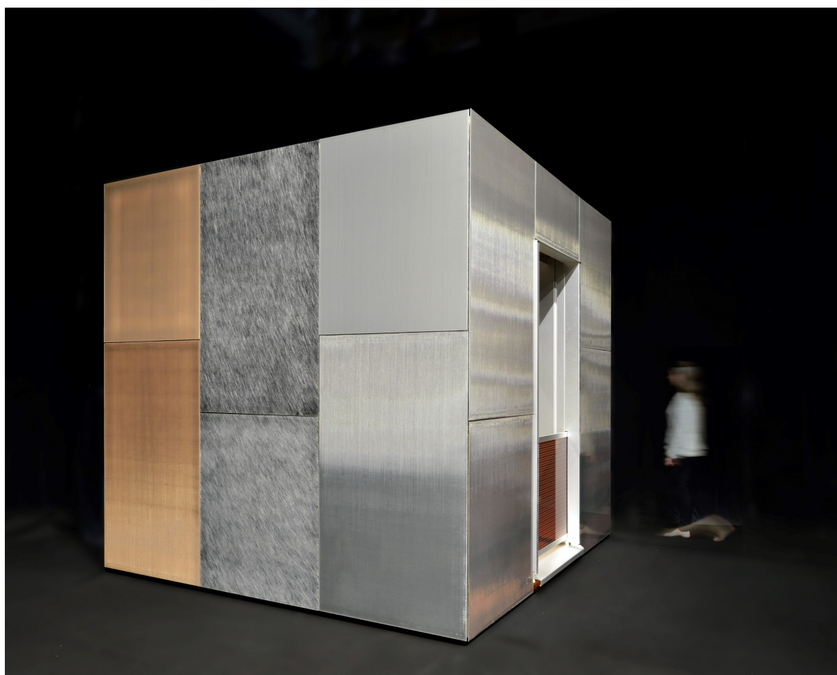
Le cube de démonstration présente à l'échelle réelle les possibilités esthétiques et techniques des nouveaux éléments de façade à cellules photovoltaïques intégrées. Source : Final report Perret-Aebi
