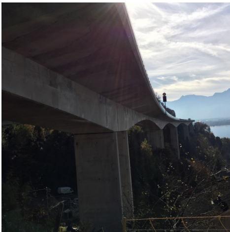
Monitoring des constructions en béton
