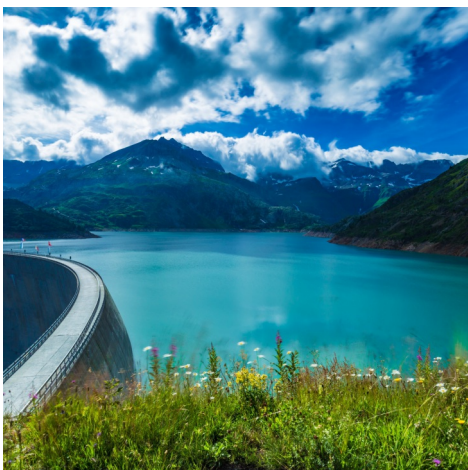
Durabilité de l'hydroélectricité
