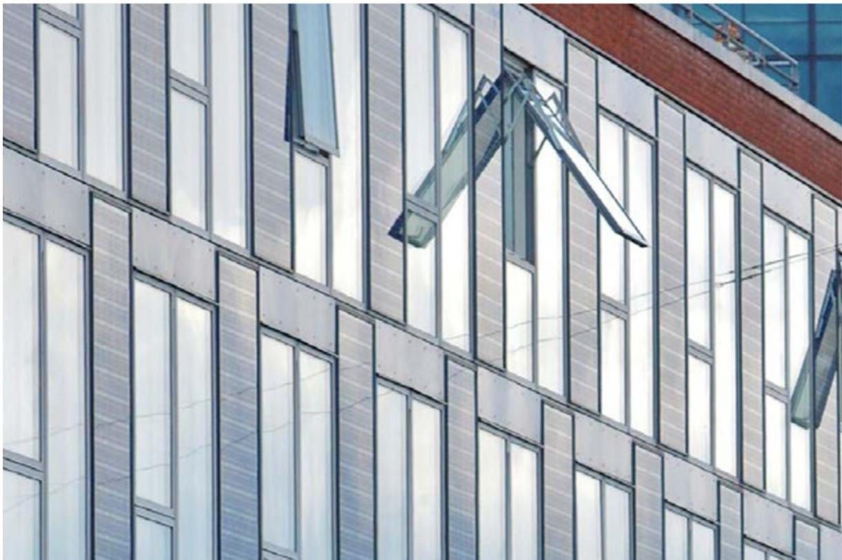
Des modules photovoltaïques directement intégrés dans l'enveloppe du bâtiment permettent d'utiliser d'énormes surfaces pour la production d'électricité. *Source* : [activeinterfaces.ch](http://activeinterfaces.ch)
