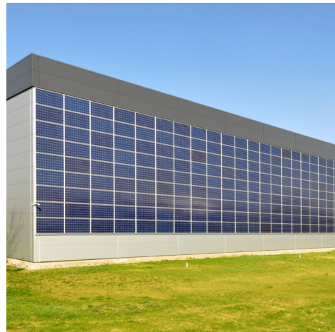
Photovoltaïque et réorganisation du tissu urbain
