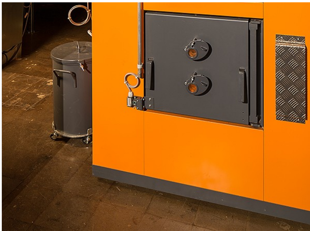
Les installations de combustion automatisées permettent de profiter de l'énergie du bois sans pollution excessive de l'air. Source : Schmid AG energy solutions
