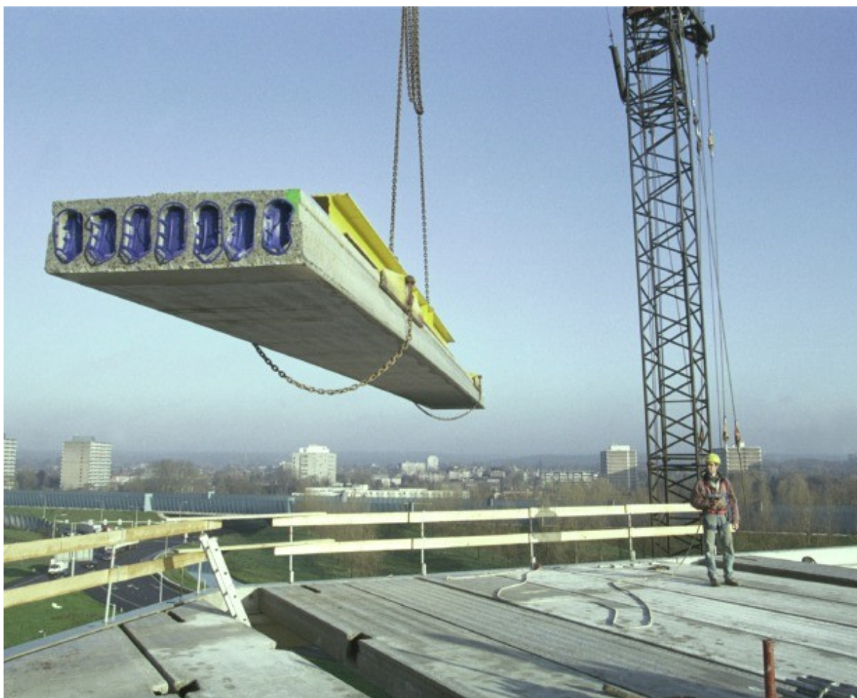
Le béton est précontraint pour le rendre plus résistant à la traction. Source : Wikicommons/Michael Schmahl
