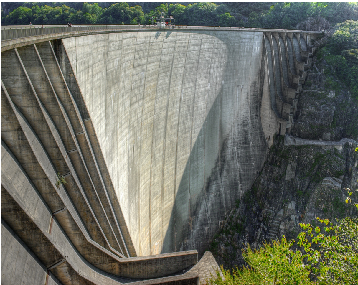
Le barrage de Contra dans le Val Verzasca au Tessin. Source : Wikimedia Commons
