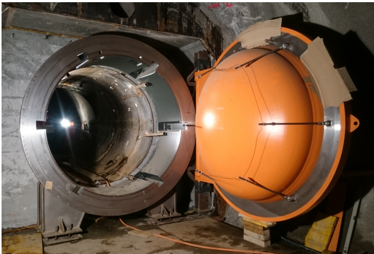
Accumulateur d'air comprimé dans les Alpes : site pilote servant à tester le stockage de l'électricité issue de sources d'énergie renouvelables. Source : ALACAES
