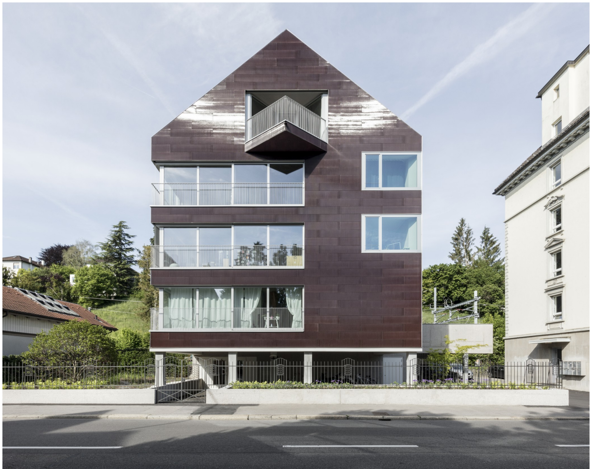
La façade en modules photovoltaïques imprimés de l'immeuble « Solaris » à Zurich couvre les besoins en électricité des locataires. Source : Beat Bühler
