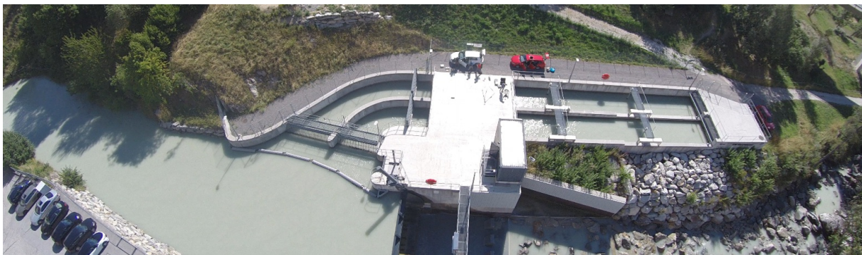
Die Entsandungsanlage Wysswasser bei Fiesch im Kanton Wallis. VAW / ETH Zurich
