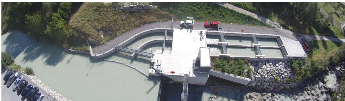
Die Entsandungsanlage Wysswasser bei Fiesch im Kanton Wallis. VAW / ETH Zurich
