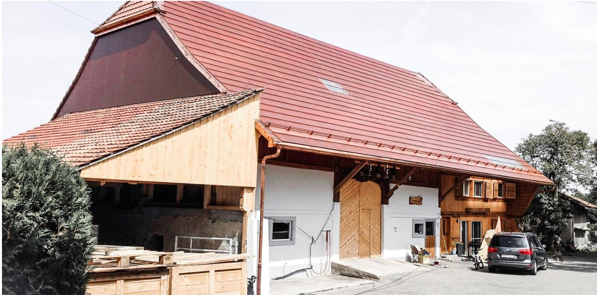
**PV-Module aus Terra-cotta als Dachziegel.** *Quelle: Projekt «Strategien für gebäudeintegrierte PV»*
