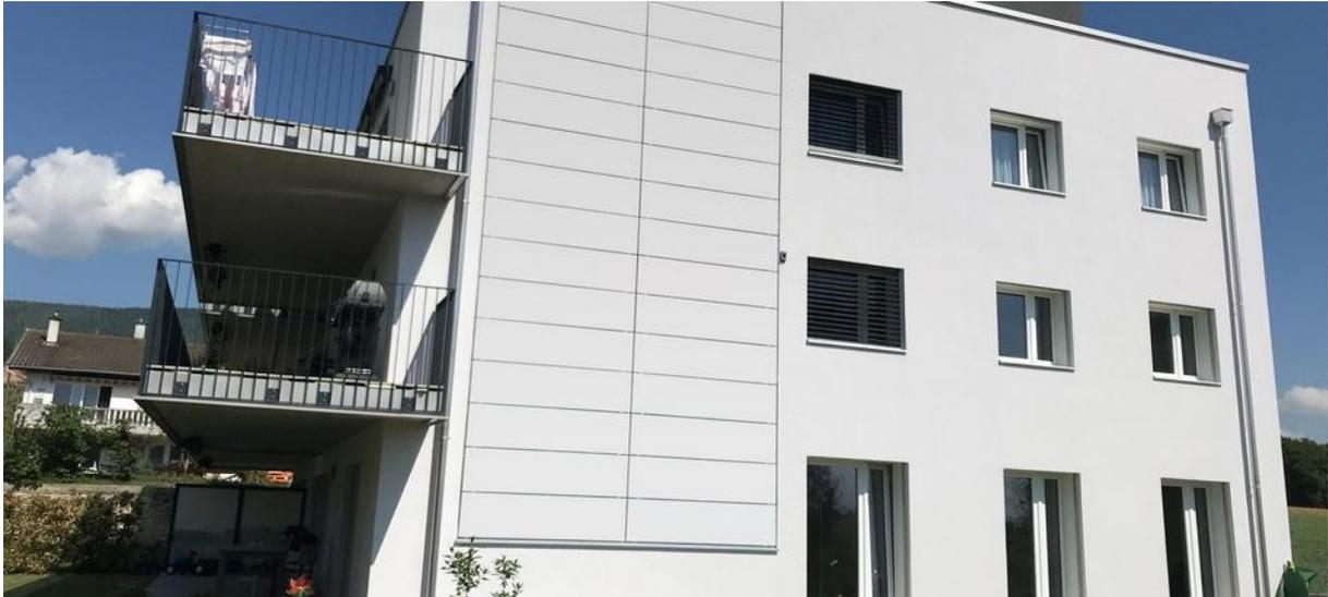
Weisse Photovoltaik-Module an einer Gebäudefassade integrieren sich quasi nahtlos in die architektonische Gestaltung. Solaxess
