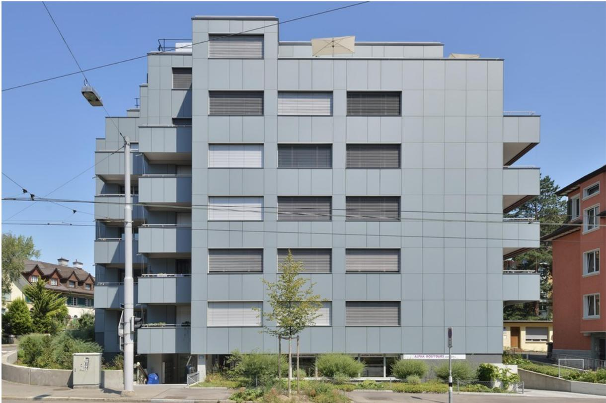
Graue Maus? Keineswegs – in die Fassade dieses Mehrfamilienhauses in Zürich integriert sind Photovoltaik-Module.
