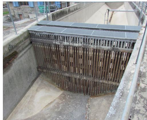
Solche Rechen in den Becken beruhigen die Strömung und tragen zur effizienten Entsandung bei.
