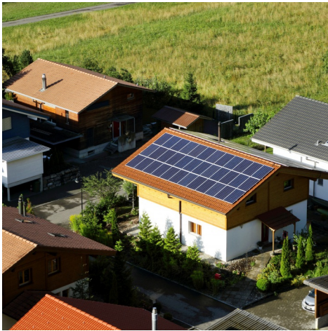
Energieinfrastrukturen der Zukunft
