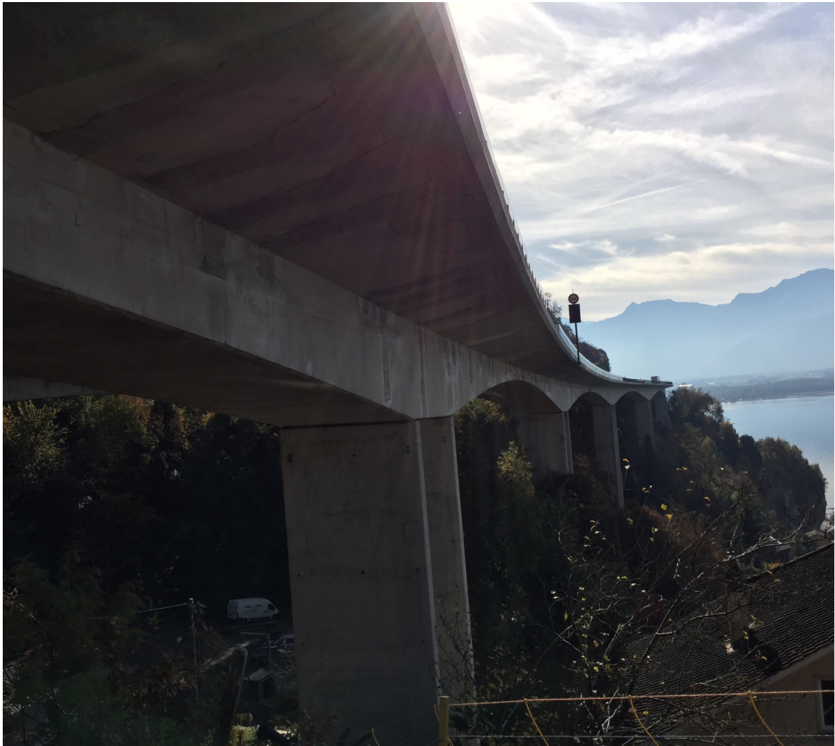
Die Chillon-Brücke wurde mit ultrahochfestem, faserbewehrtem Beton saniert. Quelle: Eleni Chatzi
