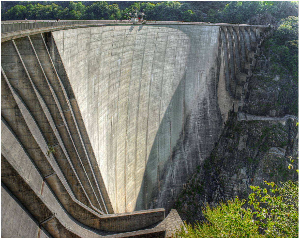
Die Staumauer Contra im Val Verzasca im Kanton Tessin. Quelle: Wikimedia Commons
