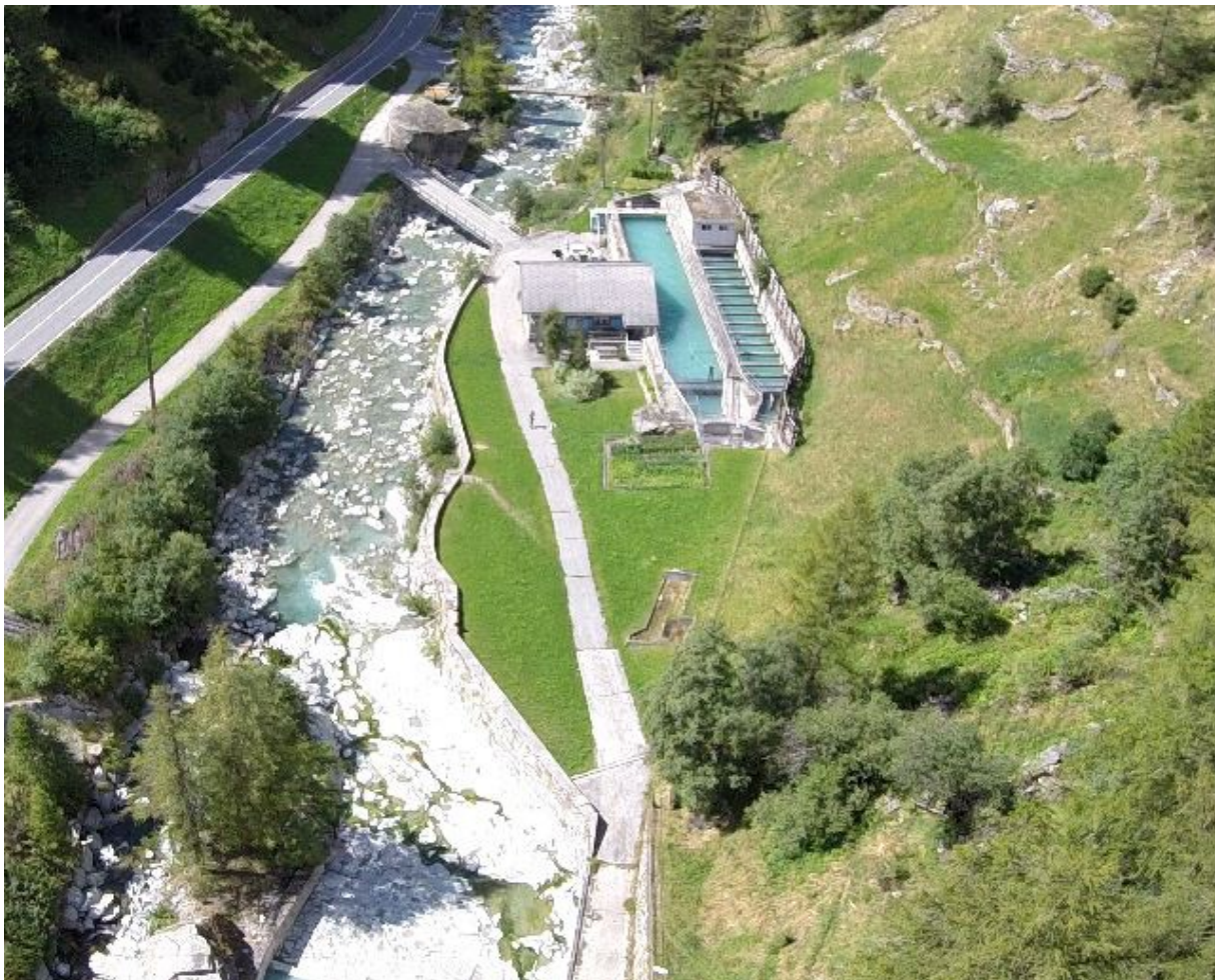
Bevor das Wasser Turbinen antreiben kann, muss es mit Entsanderanlagen gesäubert werden: Eine Anlage bei Saas-Balen im Kanton Wallis. Quelle: VAW / ETH Zurich
