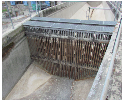
Solche Rechen in den Becken beruhigen die Strömung und tragen zur effizienten Entsandung bei. Christopher Paschmann / ETH Zurich
