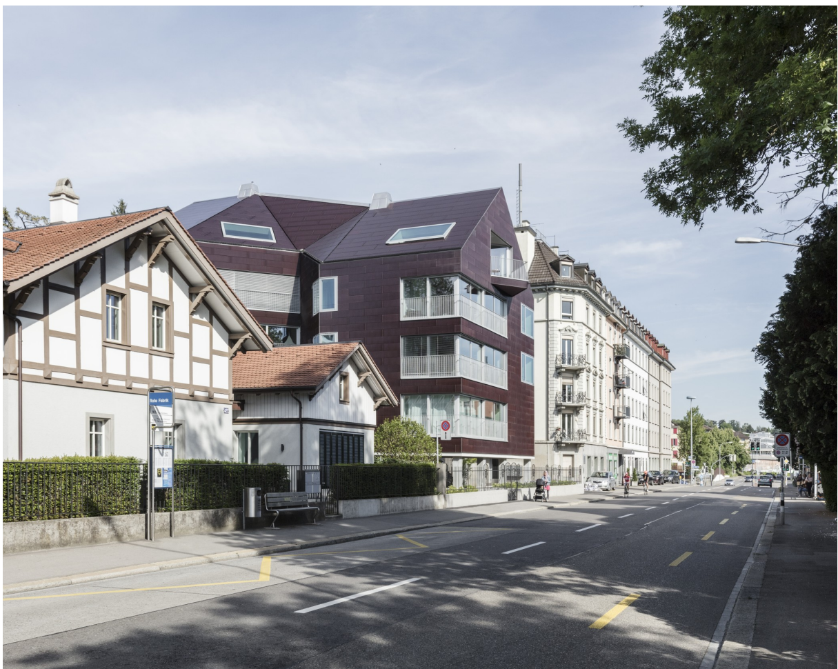
Um die Bevölkerung von Photovoltaik an Gebäuden zu begeistern, braucht es gute Demonstrationsprojekte, wie dieses Haus in Zürich mit einer aktiven Fassade. Quelle: Beat Bühler
