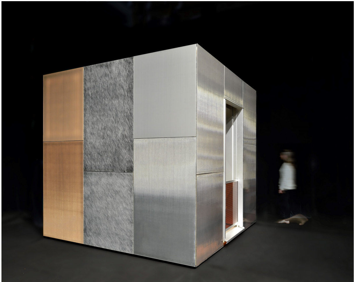
Der Demonstrationswürfel zeigt im Originalmassstab die ästhetischen und technischen Möglichkeiten der neuen Fassadenelemente mit integrierter Photovoltaik. Quelle: Final report Perret-Aebi
