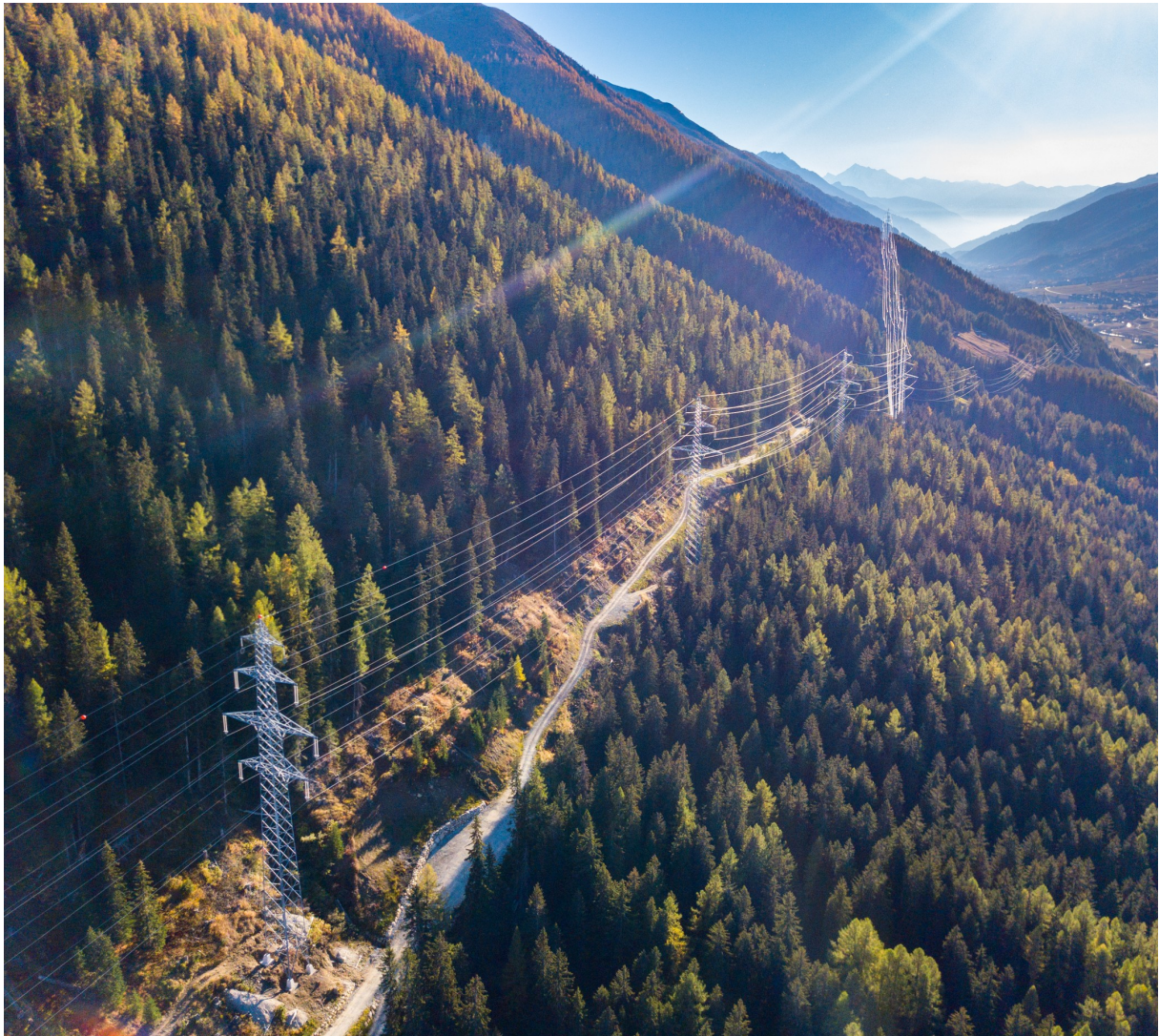
Hochspannungsleitungen sind nötig, um importierten Strom ohne das Risiko von Unterbrüchen in die Schweiz zu bringen: Eine Leitung im Wallis. Quelle: Adobe Stock
