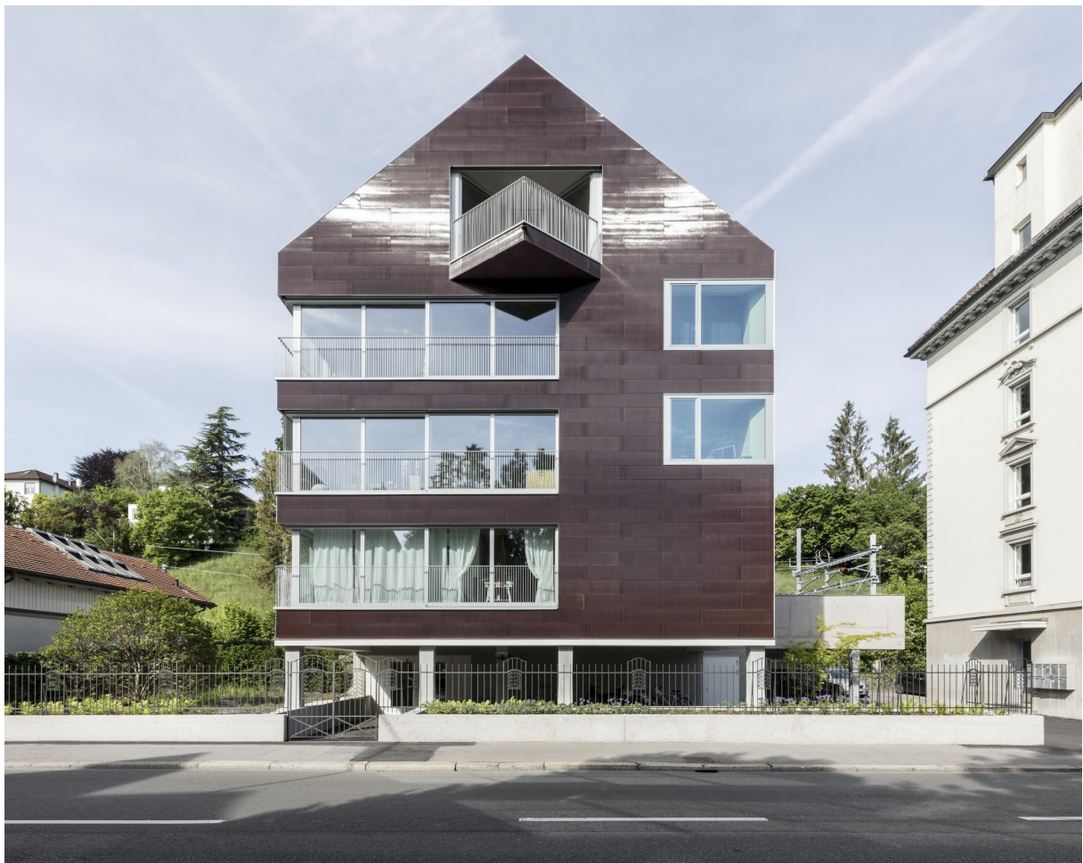
Am Wohnhaus «Solaris» in Zürich deckt die Fassade aus bedruckten Photovoltaikzellen den Strombedarf der Mieter. Quelle: Beat Bühler
